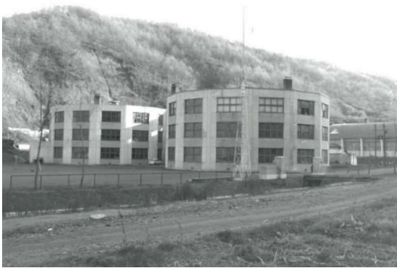
改築後の沼東小学校
