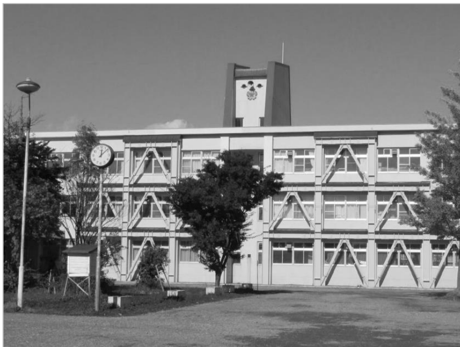
図 4.3 耐震化の実施例（中央小学校）
