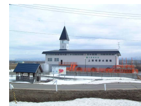
上美唄排水機場の L PWA 基地局設置予定
