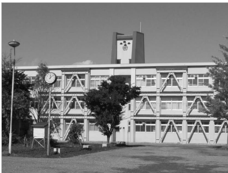
図 4.3 耐震化の実施例（中央小学校）
