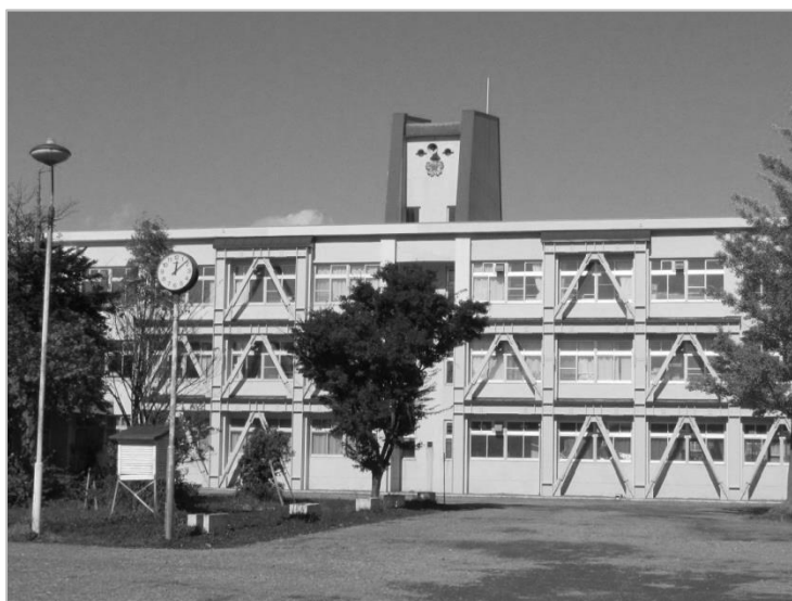
図 2. 2. 6 耐震化の実施例（中央小学校）
