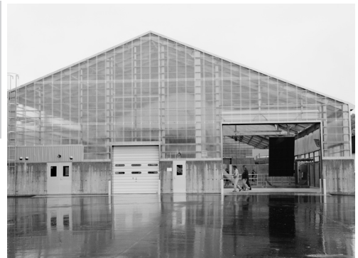
生ごみ堆肥化施設
