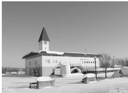
上美唄排水機場
