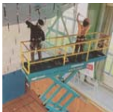
施設の整備をしている 様子
