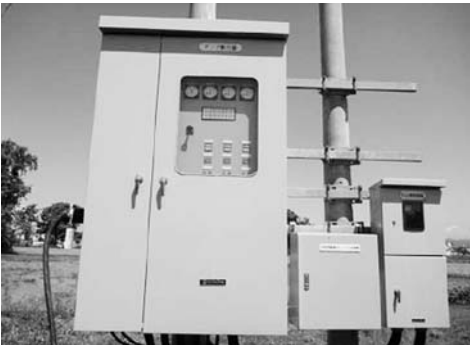
マンホールポンプ所
