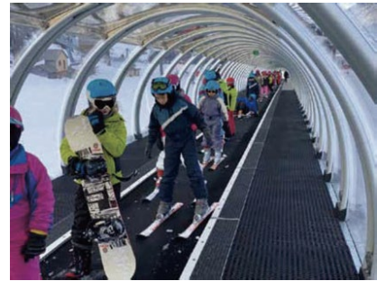
初心者搬送システムの例（ムービングベルト） 自由に昇降可能
