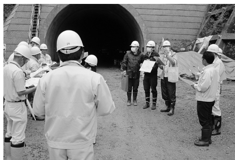
道道美唄富良野線東美唄トンネル
