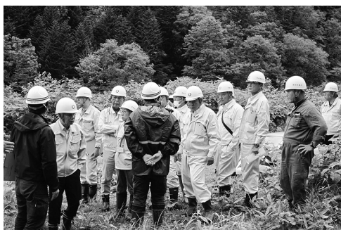
道道美唄富良野線地滑り対策工事箇所
