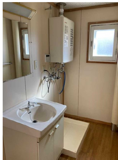
洗面・脱衣所
