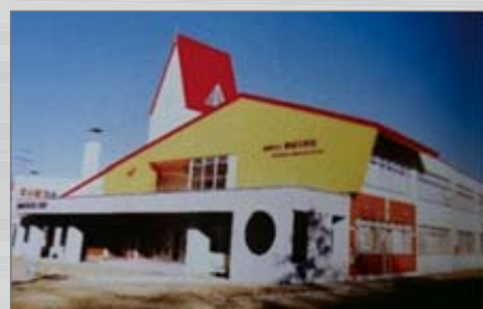
平成11年 新校舎完成
